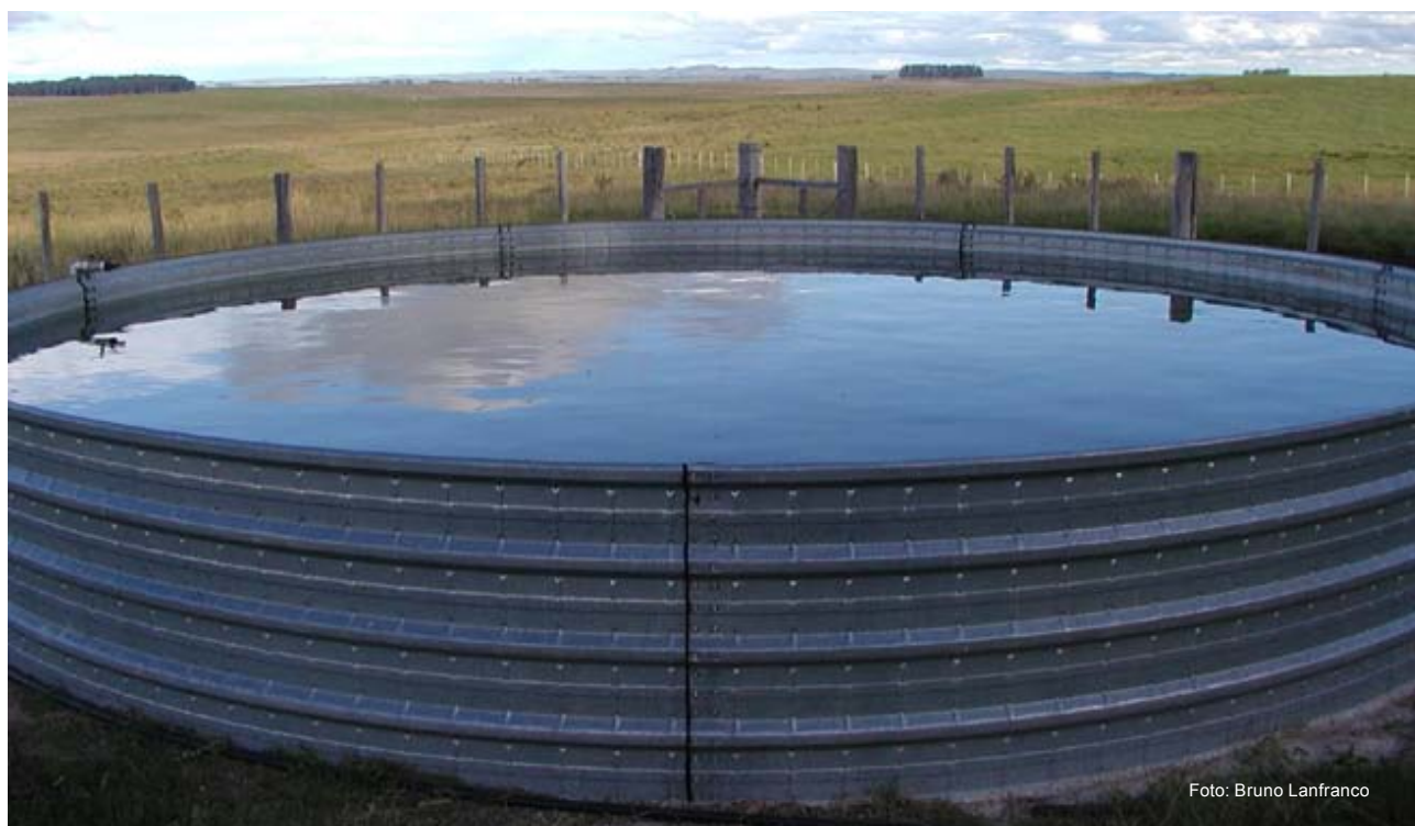
Figura 2 - Tanque australiano para distribución de agua de mejor calidad.
